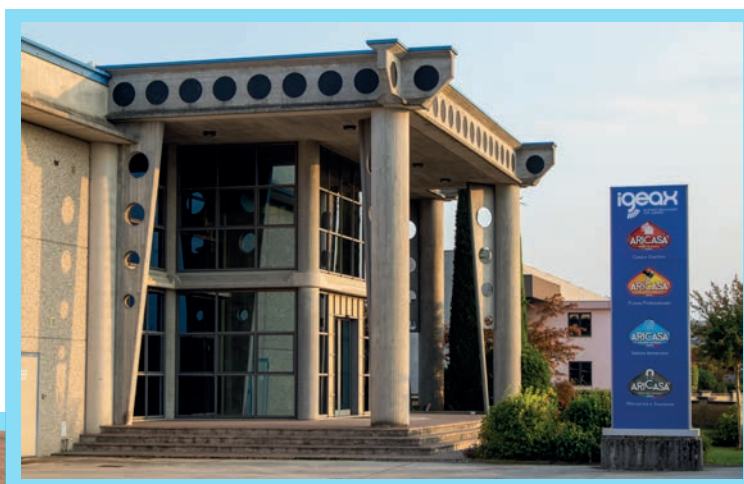
Ingresso uffici Office entrance
